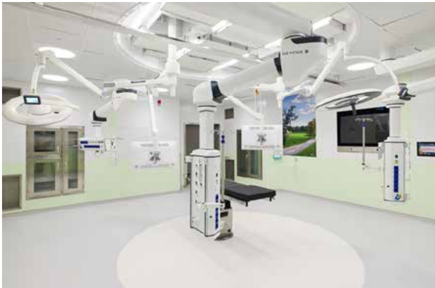
Nyköpings lasarett. Bild från en av de nybyggda operationssalarna i hus N54. På väggen i operationssalen kan man se en bild med Sörmlandsmotiv.
