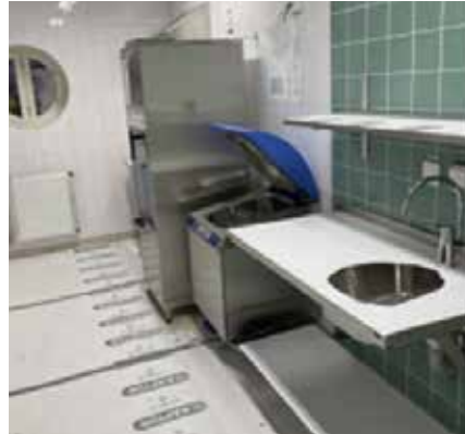
Ombyggnation av hudmottagningen på KSK är inne i slutfasen, beräknas vara klar våren 2024.
